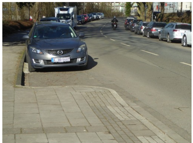
Bild 46: Gehwegvorstreckungen verdeutlichen die Lage der Fahrgasse.
