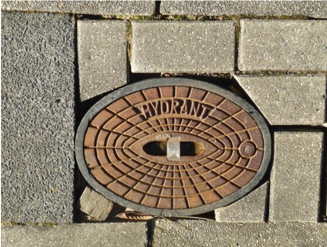
Bild 14: Hydranten im Gehweg benötigt die Feuerwehr.
