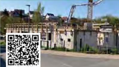
Inzwischen ist die Decke über dem EG ausgeschalt, die Stahlstützen im OG werden armiert und die Mauerwerks-Wände werden gestellt.
