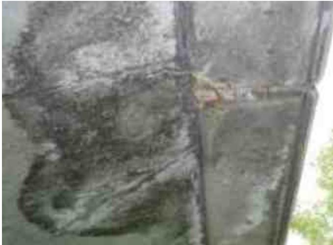
Undichtigkeiten bei Kappenfugen
