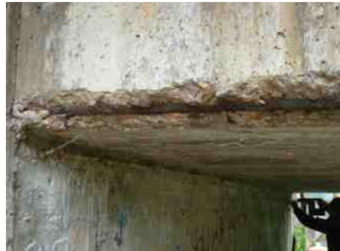
**starke Korrosion mit Querschnittsverlusten**
